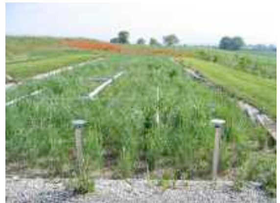
Des bouches d'aération permettent l'oxygénation du système, indispensable au fonctionnement des bactéries
